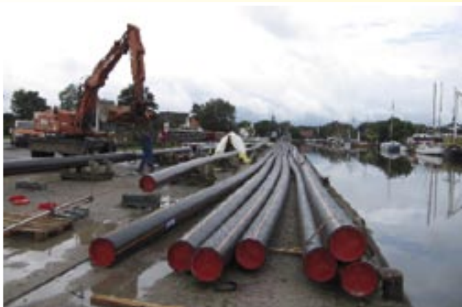
Verschweißen der Rohrstränge zu je 132 m im Vareler Hafen
