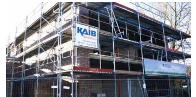
November 2016: So sieht es aktuell auf der Baustelle aus: Das Dach ist geschlossen, die Klinker sind vermauert. Jetzt kann es an den Innenausbau gehen. Bis zum geplanten Einzug 2017 sollte alles fertig gestellt sein.
