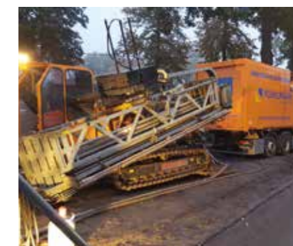
Bohranlage samt Technik
